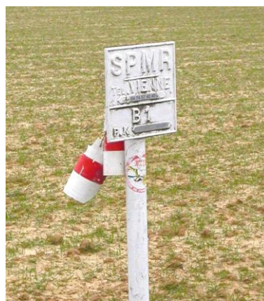
Borne de signalisation du Pipeline Méditerranée-Rhône
